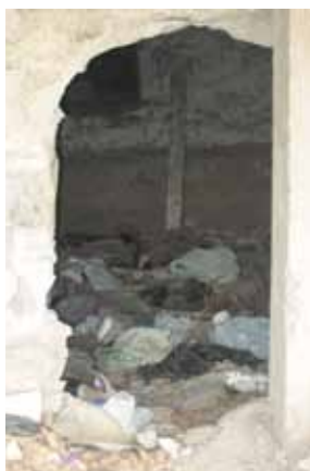
Las ratas se pasean a toda hora del día. La casona está construida sobre un túnel y por la humedad los roedores se reproducen indiscriminadamente. En la gráfica se aprecia ese lugar lleno de humedad, suciedad, ratas y cucarachas.
